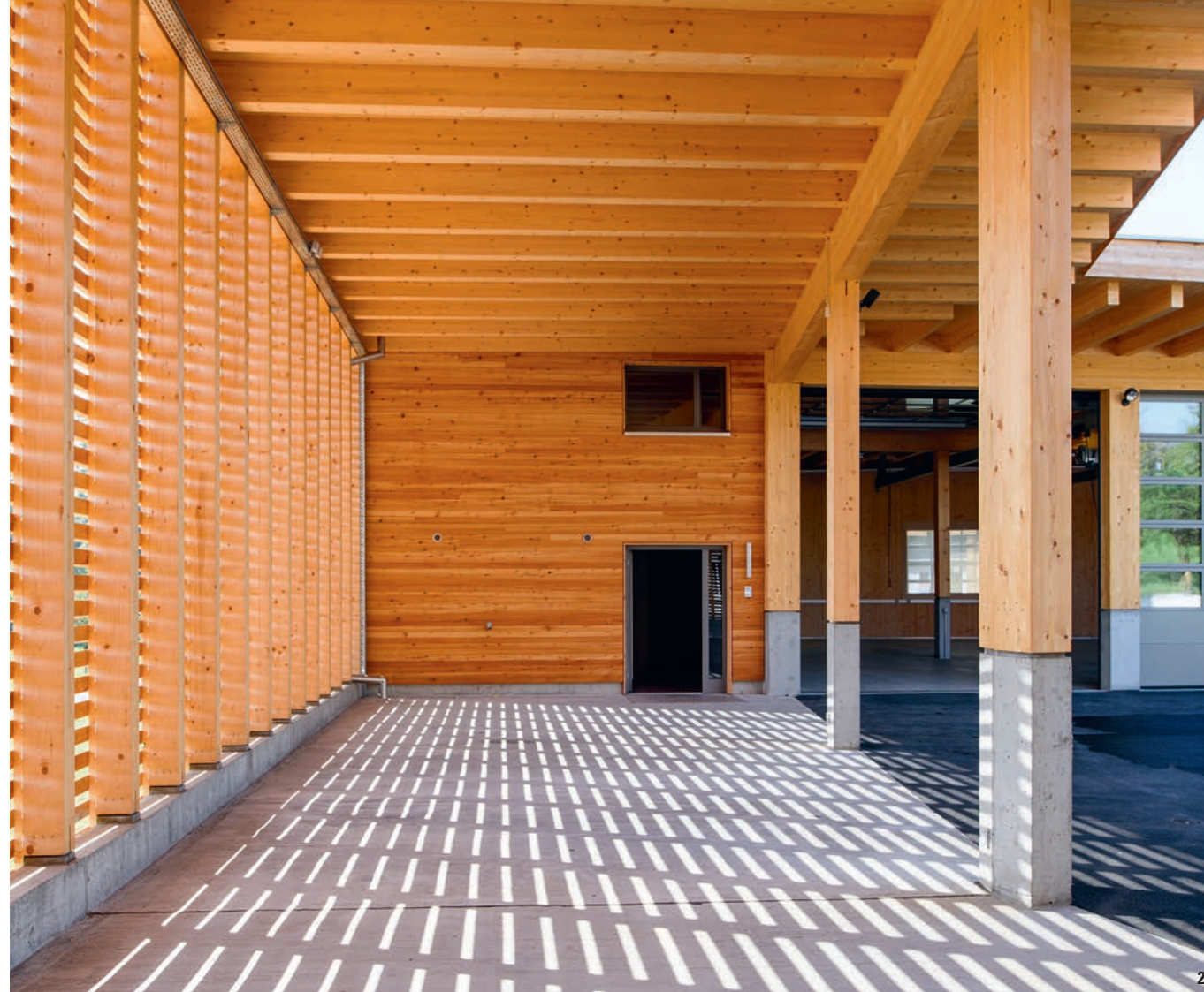
1 Das Silo markiert das Zentrum des Innenhofs. Auch für einen grossen Sattelschlepper muss der Platz zum Rangieren ausreichen. 2 Die offene Lattung aus Lärchenholz bildet ein reizvolles Lichtspiel, schafft Transparenz und dient gleichzeitig als Witterungsschutz.
