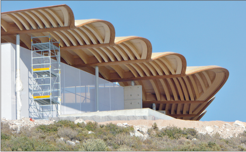
Die „Wellenberge“ werden aus 187 Sekundärbalken geformt. Mit einer 7,5 m langen Auskragung sollen sie der Terrasse Schatten spenden.
