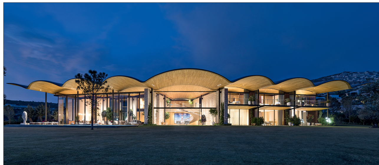
Das Holzdach der Villa lässt an die Wellen des Meeres denken. Mit diesem Stilmittel schaffen es die Architekten, die gigantische Dachlandschaft harmonisch mit der Umgebung zu verschmelzen.
