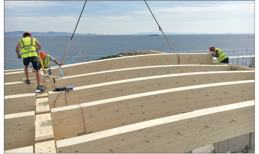
Das Dachtragwerk wird von Primärträgern aus Eiche und „Baubuche“ mit dazwischen gespannten Sekundärträgern aus Fichte gebildet.
