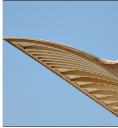
Bei den Hauptträgern ist der untere Teil aus massiver Eiche. Die Tragbalken sind im vorderen Bereich mit „Baubuche“, im hinteren Teil mit Fichte verstärkt. Fotos: Blumer-Lehmann AG
