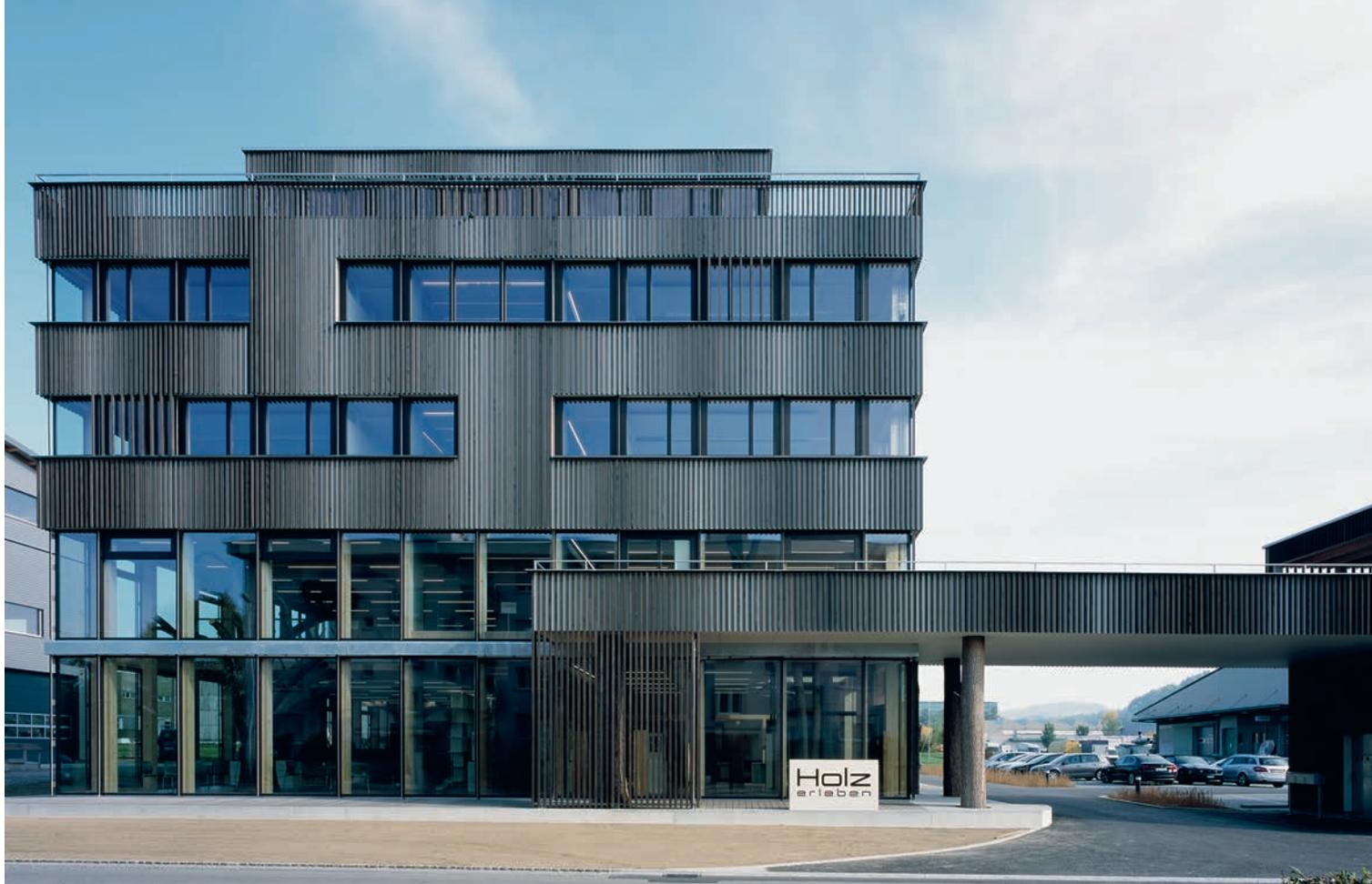
Der fünfgeschossige Holzbau der Braun AG in Gossau (SG) beherbergt in den beiden unteren Geschossen die Ausstellungsräume. Die Wirkung der Fassade wird durch 13 unterschiedlich tiefe Lattendimensionen verstärkt. Der Betrachter nimmt diese als eine Art Wellenbewegung wahr, auch Dopplereffekt genannt.
