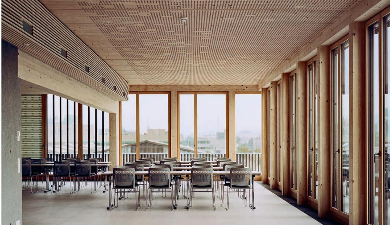
Für die Deckenelemente – wie hier im Attikageschoss – wurden 3100 Quadratmeter Lignatur-Elemente verbaut.
