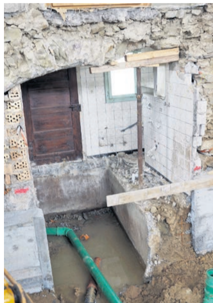
Bauzustand: Ein bestehendes Fundament stabilisierte das Bauteam fachgerecht.
