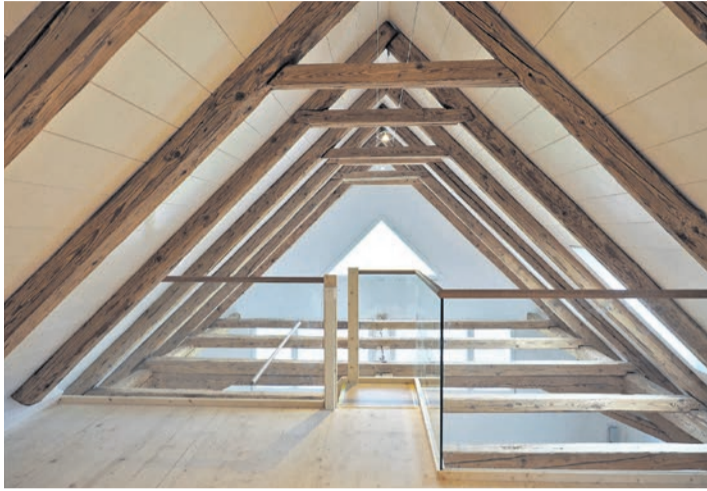
Diesen Dachraum baute die Blumer-Lehmann AG grosszügig aus.
