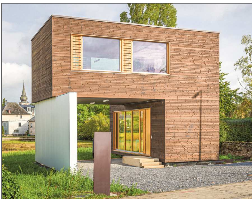
Die drei Module wurden an ihrem neuen Standort in Moutfort (Luxemburg) gestapelt neu aufgebaut. Foto: FAT Architects/Jan Malburg (Medienhaus-Lu)
