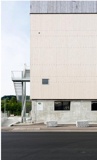
Sichtbar unterschiedlich: vorgegrautes Holz im oberen Teil und UVood-behandeltes Holz unten.
