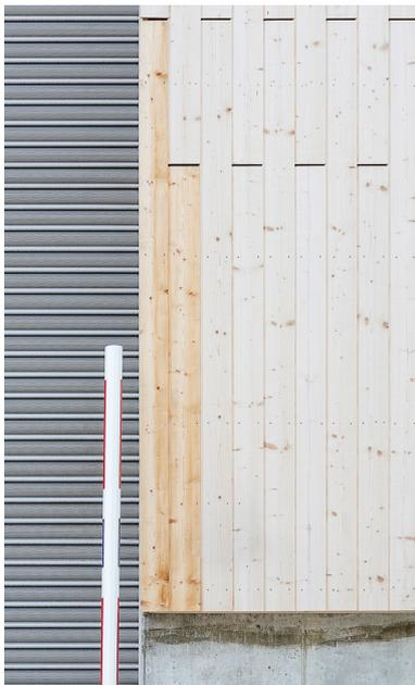
Die mit UVood behandelte Fassade im direkten Vergleich zu einigen naturbelassenen Fassadenbrettern.
