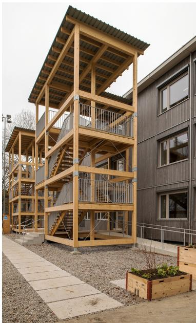
Das dreigeschossige Schulprovisorium wird über die aussenliegenden Treppentürme aus Holz erschlossen.
