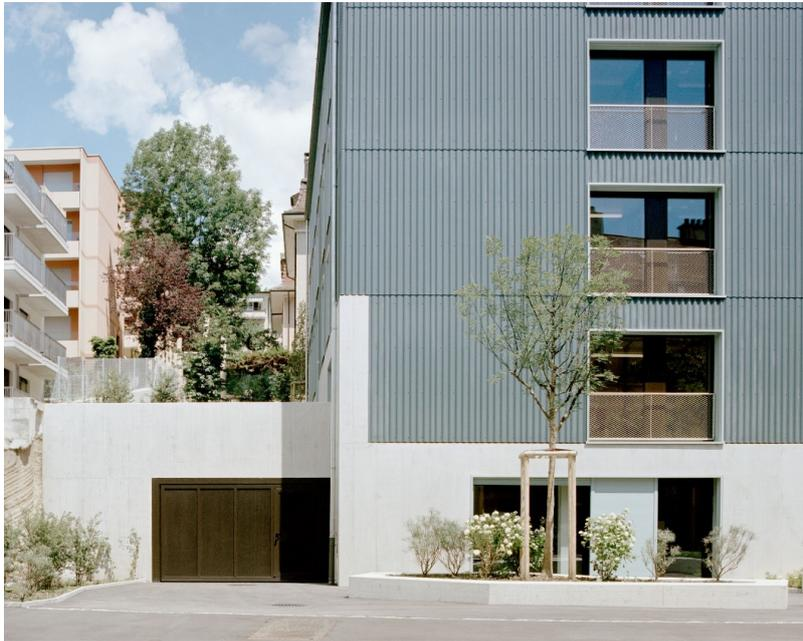
Das Gebäude wurde als Holzbau entwickelt, dessen Fassade und Dach aus Welleternit bestehen
